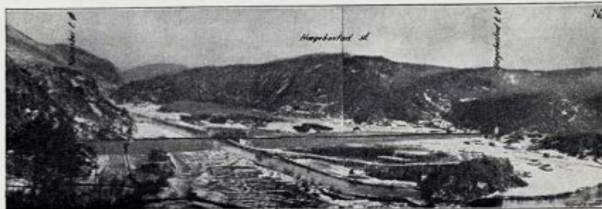
Hægebostad stasjon i Lyngdal med Kvinesheittunnelen t. v. og Hægebostadtunnelen t. h.
